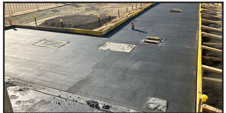
Lift entry concrete pour (above)
